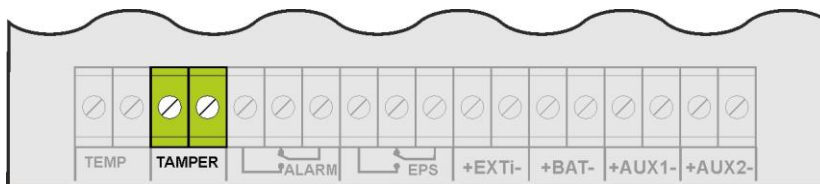
Rys. 11. Wyjście techniczne TAMPER.
